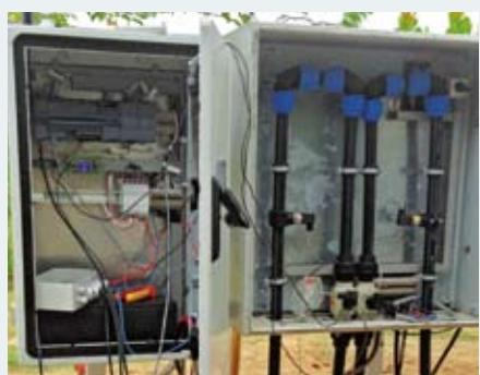
Die SPS ist mit einem internetgestützten Monitoringsystem ausgerüstet, das Messwerte mit hoher Genauigkeit erfasst, speichert und auf einem Internetportal für die Öffentlichkeit zur Verfügung stellt. Sie erfasst die Solarstrahlung sowie alle relevanten elektrischen und mechanischen Werte des Systems, wie
